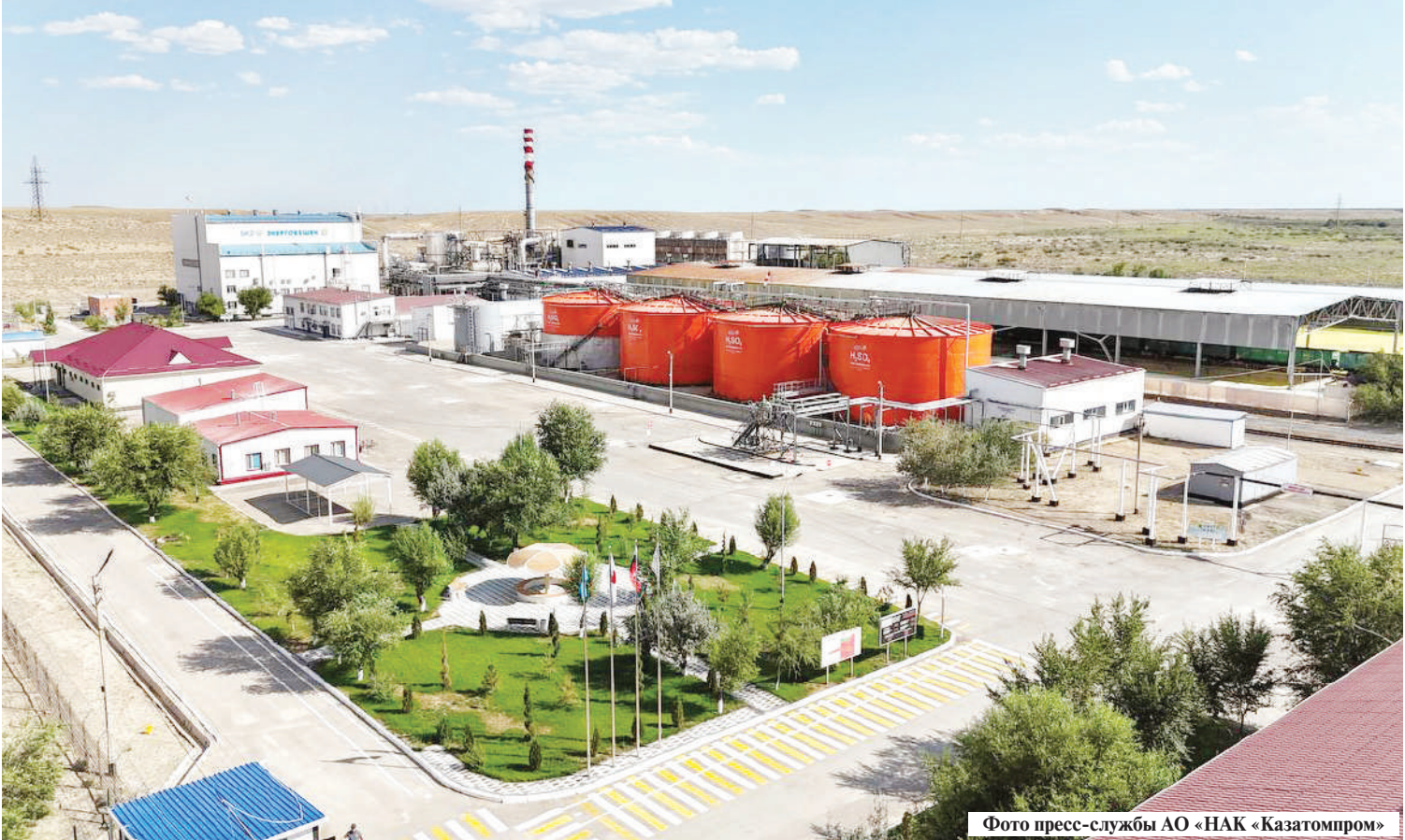
Фото пресс-службы АО «НАК «Казатомпром»
