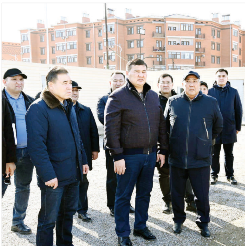
Аким области Нурлыбек Налибаев ознакомился с ходом строительства новой школы на 900 мест в Кызылорде.
