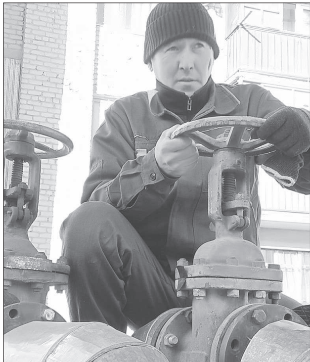
Айбергенов Жариков уже 27 лет работает в энергетической отрасли региона. Сейчас он — слесарь по обслуживанию оборудования сельского разряда эксплуатационного участка филиала ГКП «КТЭЦ».
